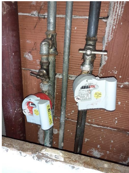
Remplacement des réseaux
