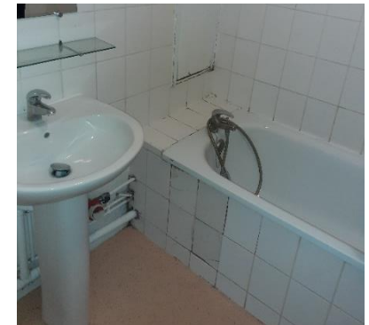
Remplacement des lavabos, baignoires si besoin ou transformation en douche
