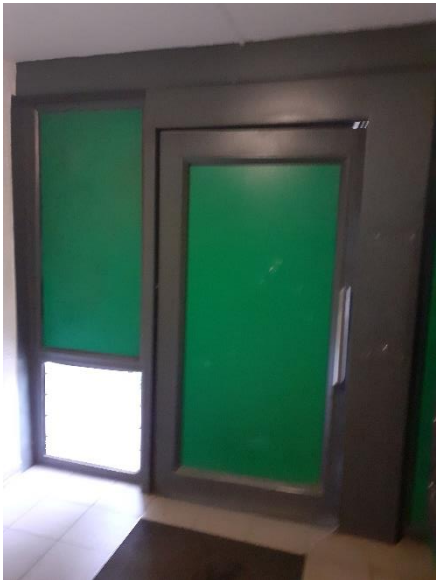
Remplacement des portes de hall avec contrôle d'accès
