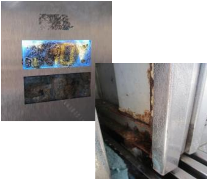
Rénovation des ascenseurs
